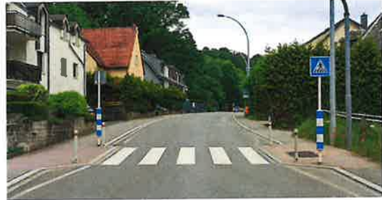
Rétrécissement latéral des deux côtés combiné avec un passage pour piétons non encore aménagé pour les personnes à mobilité réduite (PMR)
