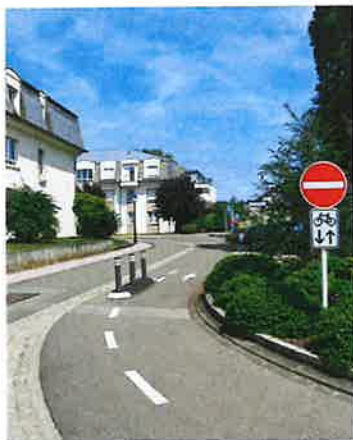
Sécurisation d'un contresens cyclable dans une zone apaisée
