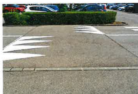
Ralentisseurs de type « sinus » avec marquage
