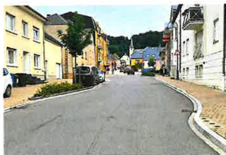
Décrochement horizontal
