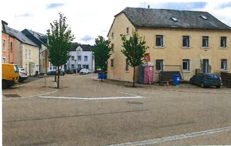
Aménagement d'une transition depuis une route de liaison limitée à 30 km/h (en avant-plan) vers une route de distribution également limitée à 30 km/h
