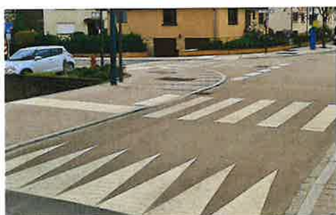
Carrefour surélevé avec revêtement clair
