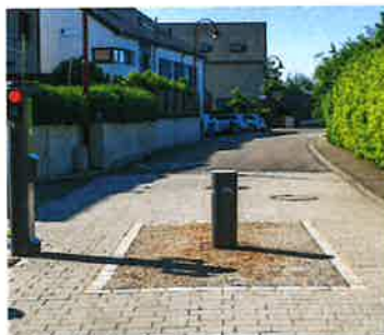
Impasse franchissable aménagée avec une borne escamotable
