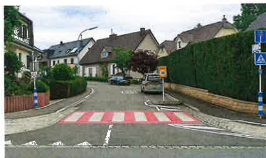
Passage pour piétons sur fond rouge : aménagement à ne plus prévoir pour les nouveaux projets d'entrée en zone 30 km/h
