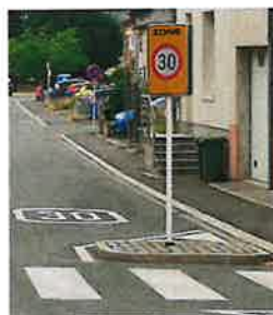
Îlot collé pour matérialiser le rétrécissement latéral
